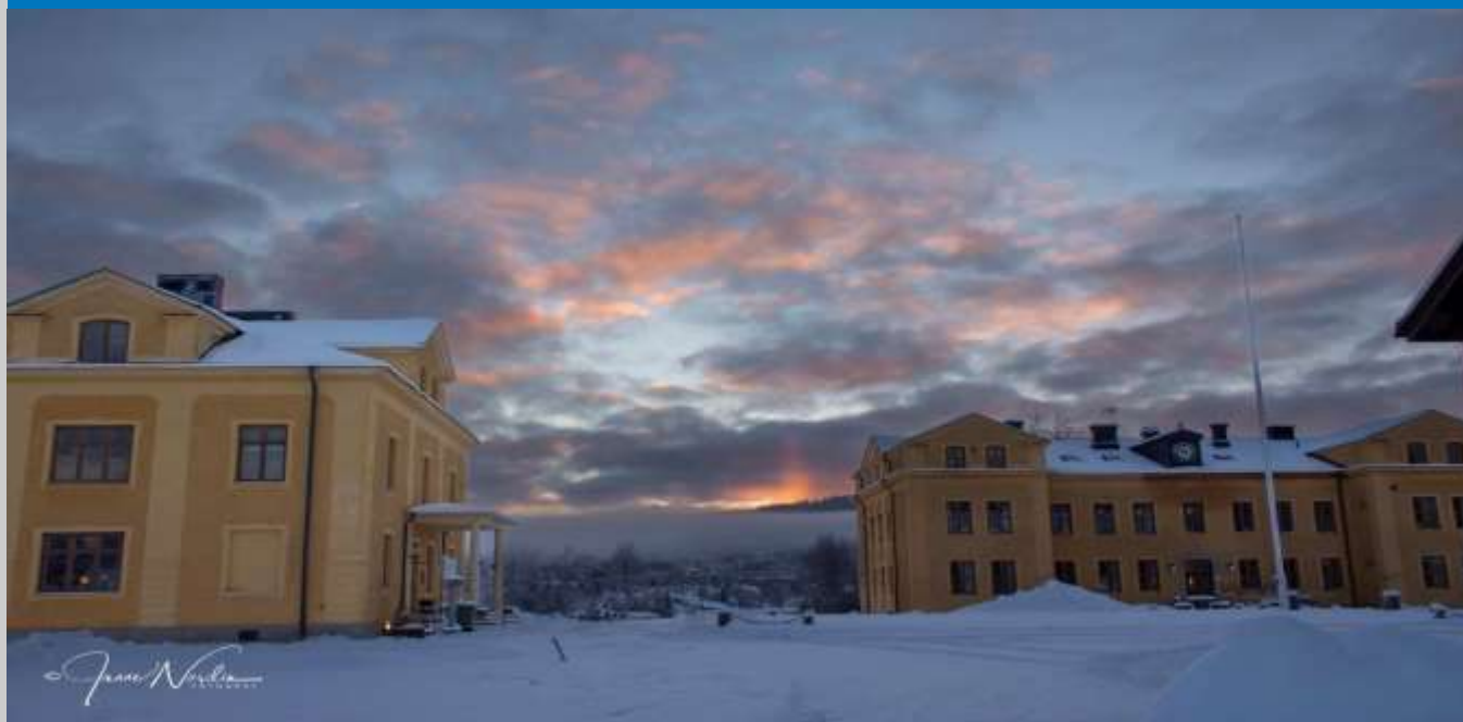
Södra kaserngården med kanslihus och klockkasern
