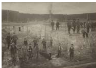
Bild från förra seklets första år visar när grunden till B-kasern uppfördes av stora granitblock och kalkbruk. Kontrollant vid bygget var kaptenen vid fortifikationsverket C L Lundqvist biträdd av löjtnanten L af Petersen.
