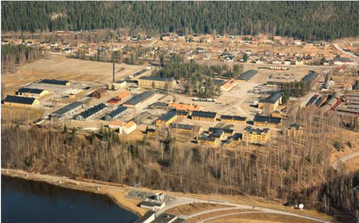
Flygfoto av T 3 och Remsle. Längst till höger i bilden Norra kaserngården och byggnaderna runt den. Till vänster i bild, västra fältet.
